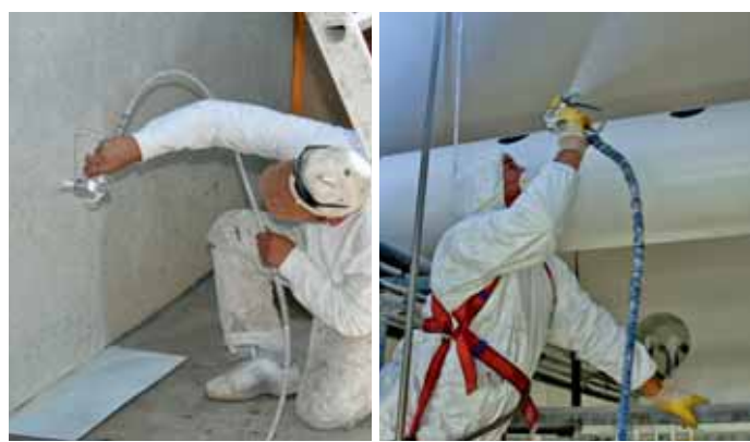
Das Aufbringen von Bioni Hygienic erfolgt im Sprühverfahren.
